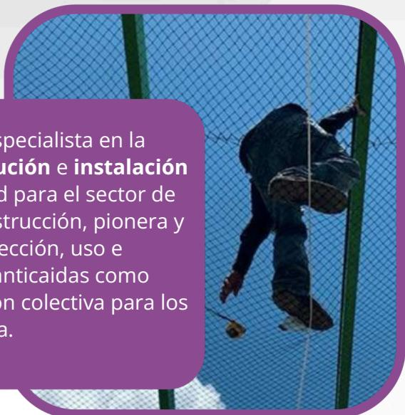
Las redes anticaídas de seguridad para construcción se instalan estratégicamente en puntos clave del edificio en construcción, como andamios, estructuras elevadas o áreas abiertas propensas a caídas. Su principal objetivo es prevenir accidentes y proteger tanto a los trabajadores como a los transeúntes o personas en áreas cercanas.
